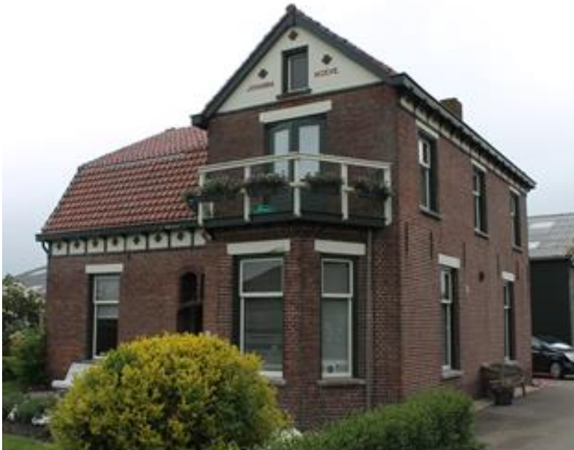
WOONHUIS NR. 57 DE JOHANNAHOEVE
