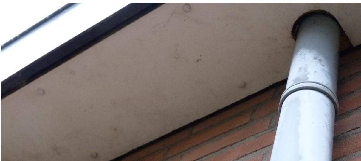
Afbeelding 4: Toegankelijke ruimte achter de dakgootombouw.
