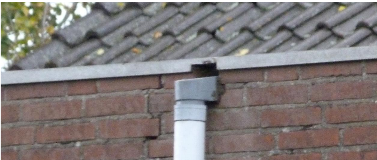
Afbeelding 3: Spouw toegankelijk via opening bij de regenpijp.
