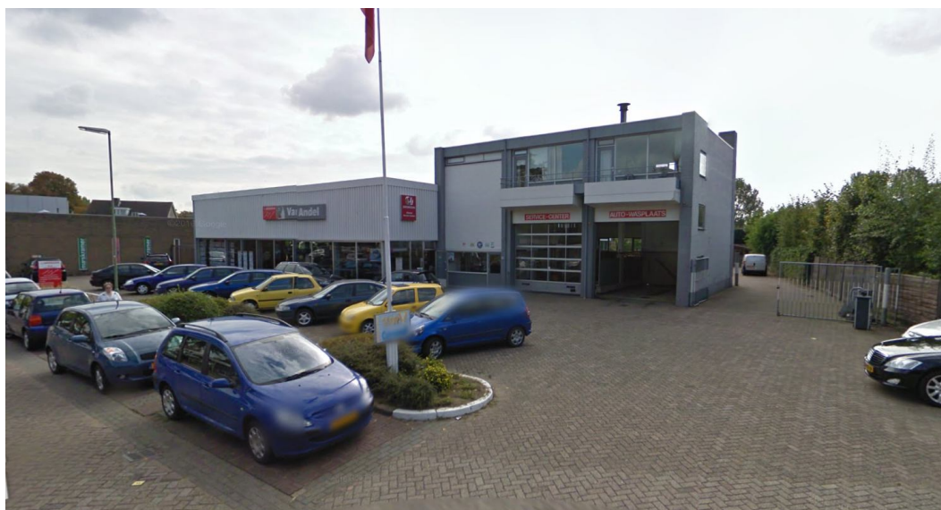
Het voormalige garagebedrijf in het plangebied voor de sloop (bron: Google Streetview)
