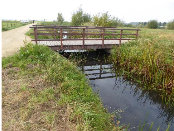
Brug aan de westzijde van het plangebied
