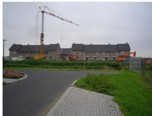
Wooncluster in aanbouw
