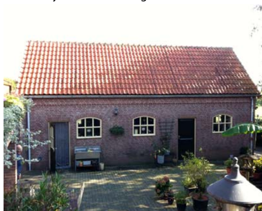
Bestaande schuur achter woning
