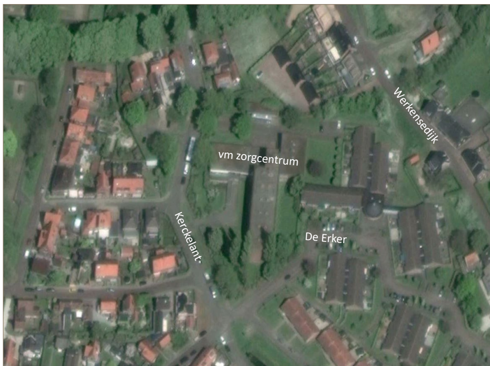
Figuur 3.2: Luchtfoto bestaande situatie
