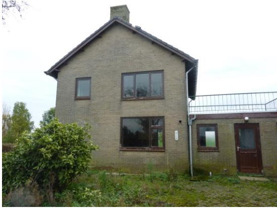
Bestaande bedrijfswoning (noordzijde)
