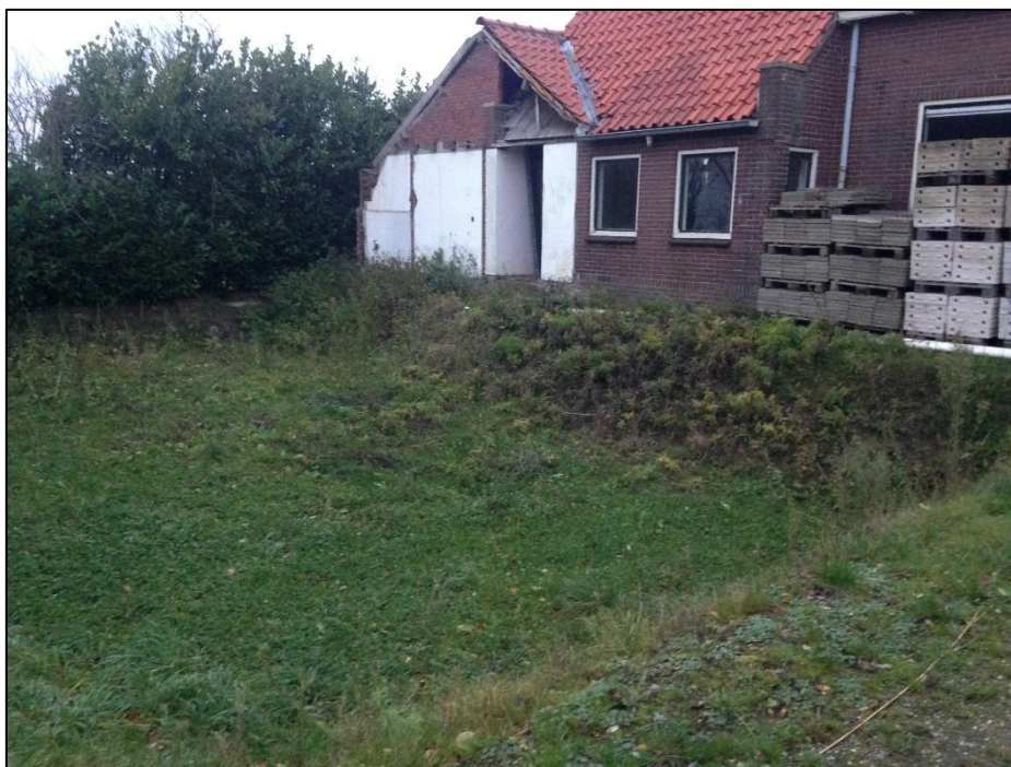
Foto 1. Ingraving in het plangebied ter plaatse van boorpunt 3.
