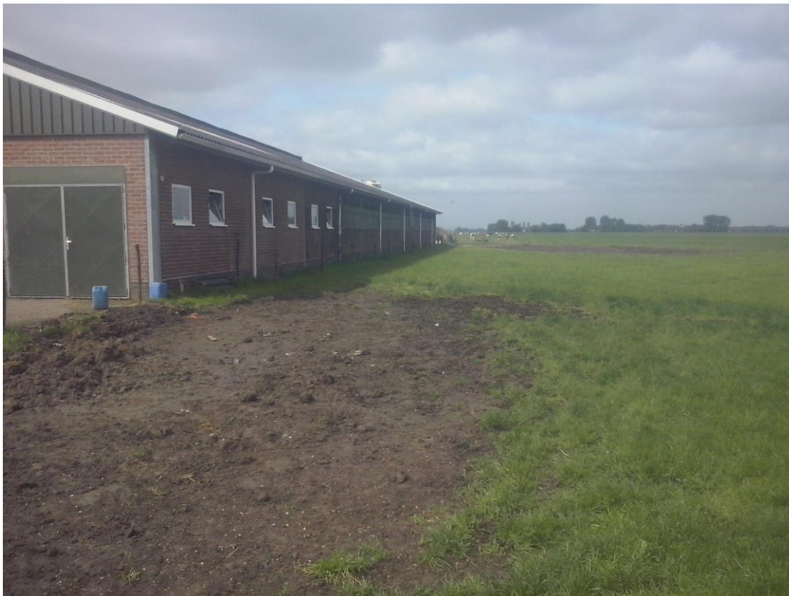
Figuur 17: Het plangebied gezien vanuit het oosten
