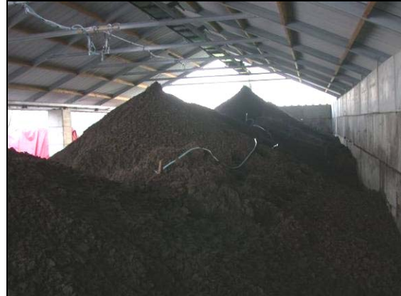
Droge mestopslag met injectieleiding op de mest en verzamelleiding in de nok
