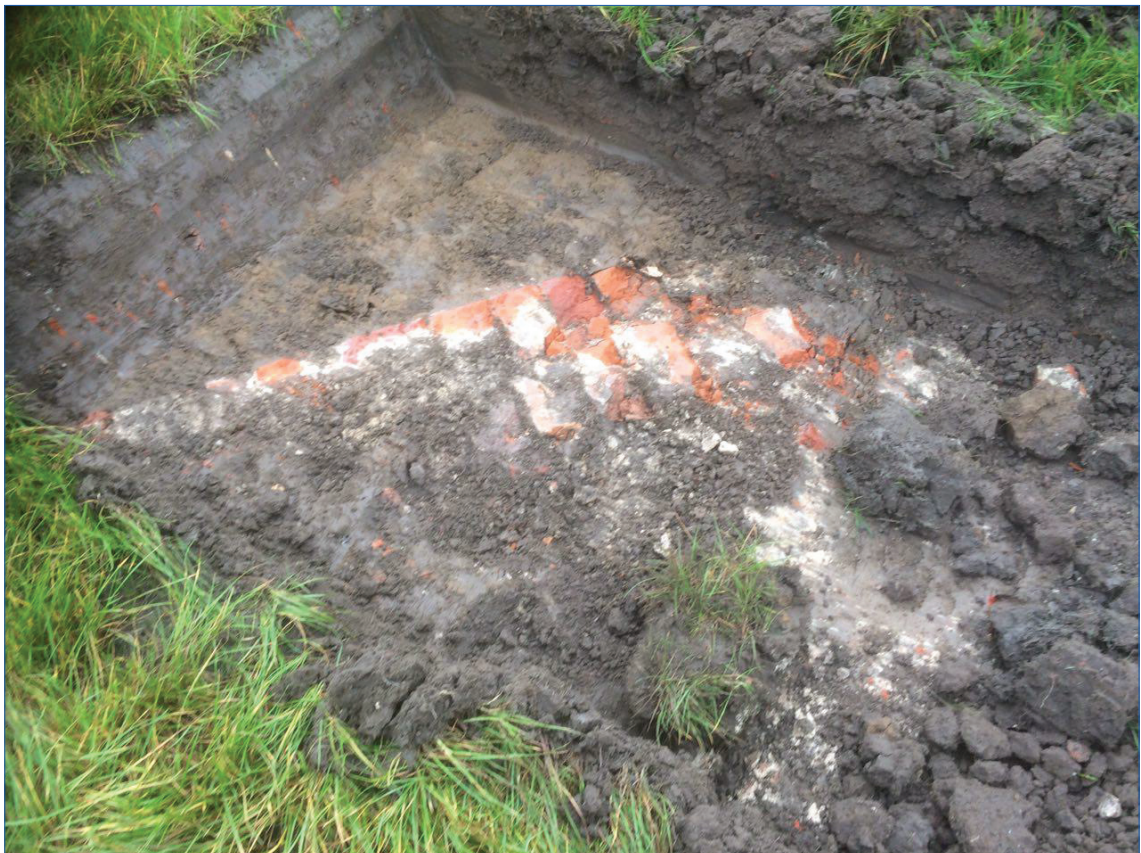
Figuur 8. Muurwerk van 'kloostermoppen', bij explosievenonderzoek aangetroffen in deelgebied 15.
