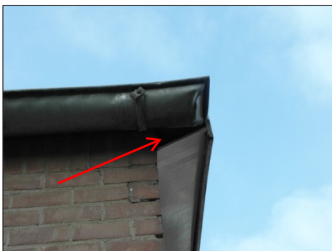
Figuur 23: ruimte tussen dak en muur
