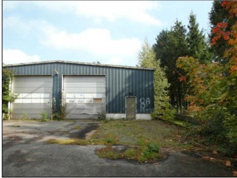
Figuur 15: leegstaande loods aan voorzijde
