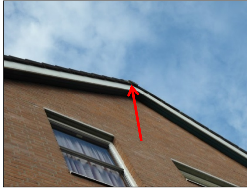
Figuur 4: ruimte onder dakpannen
