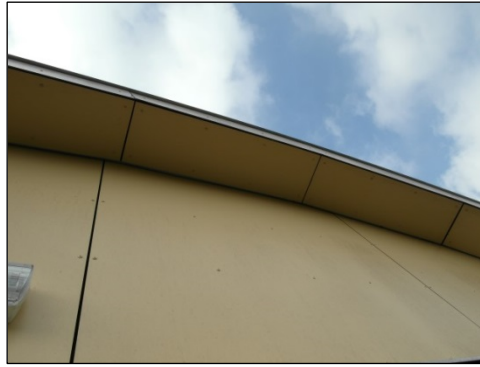
Figuur 20: afgetimmerde dakranden
