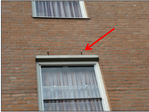
Figuur 3: stootvoegen boven de kozijnen
