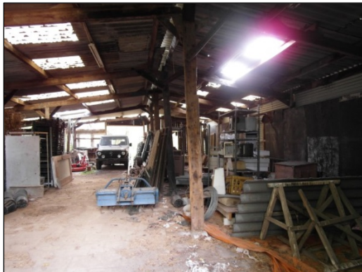
Figuur 7: binnenzijde van schuur
