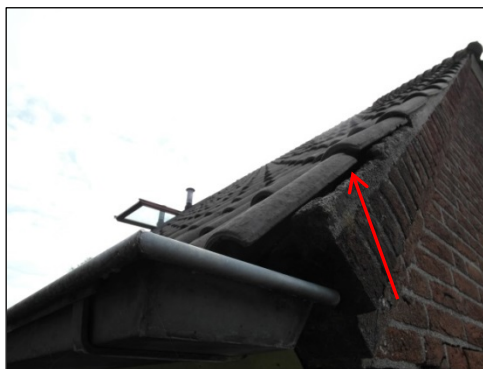
Figuur 14: ruimte tussen dakpannen mogelijk geschikt voor vleermuizen
