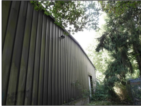
Figuur 18: zijkant gebouw met struweel en bomen eromheen
