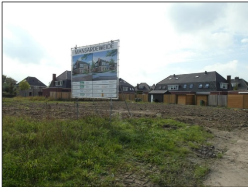
Figuur 36: plangebied voor nieuwbouw
