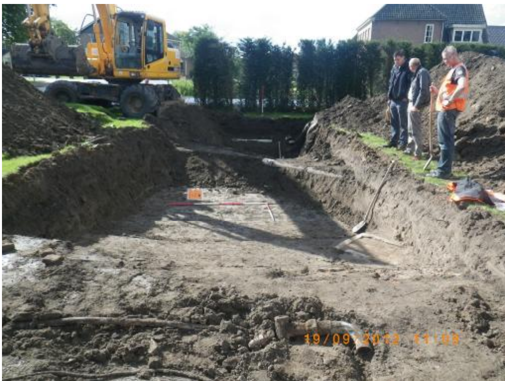
Afbeelding 2: de aanleg van werkput 1 tijdens het veldwerk. Duidelijk zichtbaar is de leiding die in de put werd aangetroffen.
