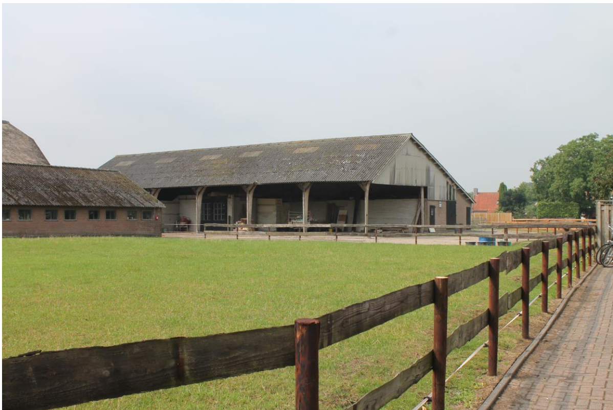
OVERZICHT VAN DE HUIDIGE SITUATIE IN HET MIDDEN DE TE SLOPEN SCHUUR, LINKS DE TE BEHOUDEN BOERDERIJ EN HET KLEINE SCHUURTJE
