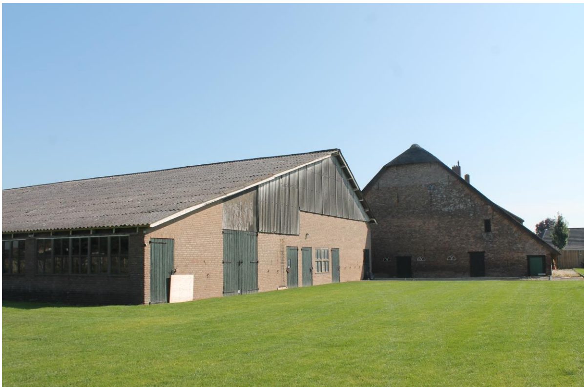
DE GESLOTEN ACHTERZIJD VAN DE TE SLOPEN SCHUUR
