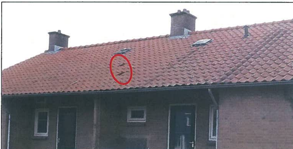
Afbeelding 9: Mogelijke invliegopening voor het ontbreken van dakpannen (rood omcirkeld), Nieuwe Steeg 15 en 17.
