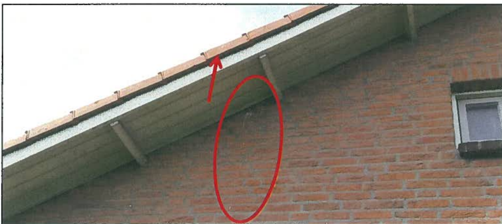
Afbeelding 11: Ontlasting van vogels bij een opening onder het boeiboord (rood omcirkeld). Daarbij is er ruimte onder de dakpannen wat als mogelijk invliegopening voor vleermuizen kan fungeren (rode pijl).
