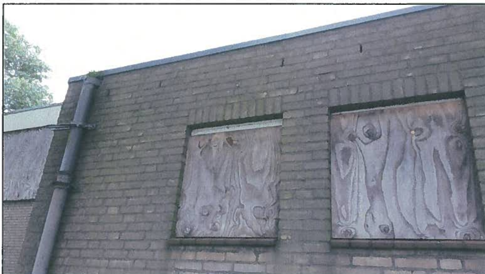
Afbeelding 4: Stootvoegen met mogelijke invliegopeningen
